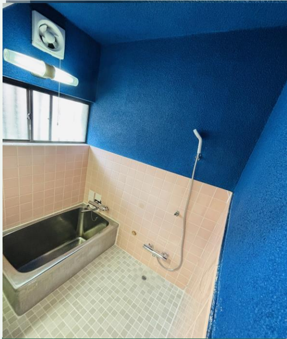
【浴室】タイル張替・混合栓2ヶ所・換気扇新品 浴槽磨き済
